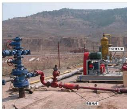
中联煤CO 2 注入地点现场
