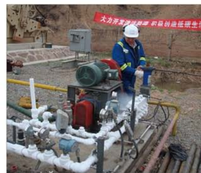
中联煤CO 2 注入地点现场
