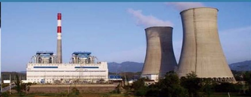
重庆双槐电厂全景
